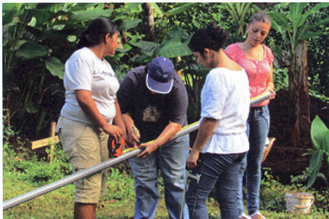
Figura 6 Preparación de la tubería.
