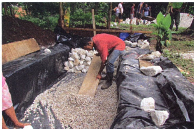
Figura 7 Acomodo de la piedra para el filtro.
