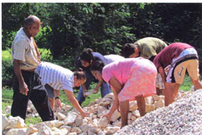
Figura 5 Selección y separación de la piedra.
