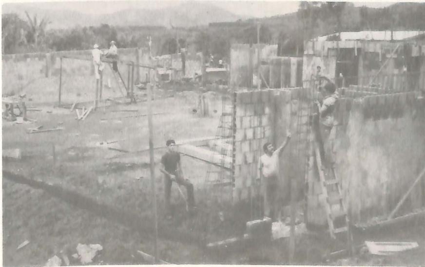
Primera Etapa de la construcción del Gimnasio.
