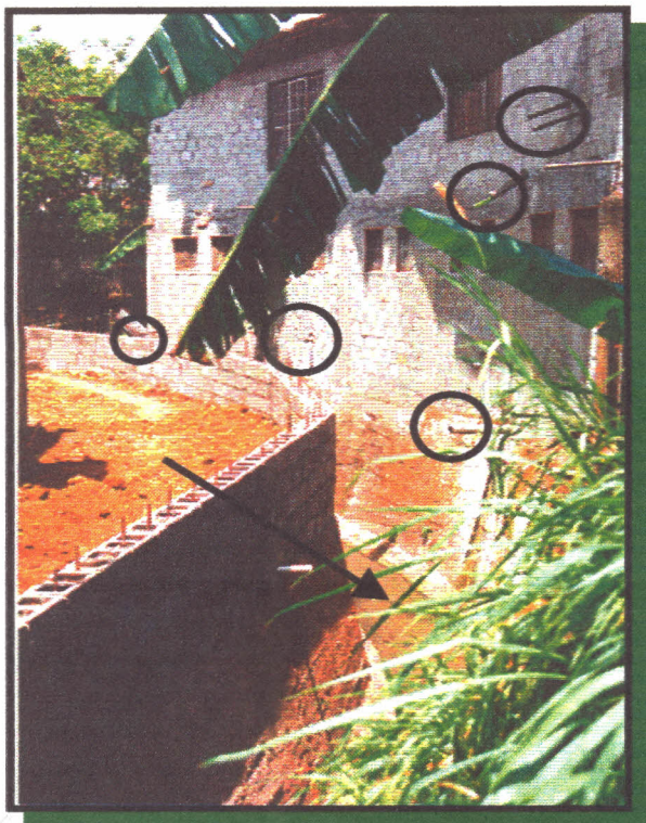
Quebrada Calabazo, Palmares, donde se nota la construcción de casas casi en el cauce y la gran cantidad de tuberías donde se lanzan aguas servidas y cloacales directamente a la quebrada
