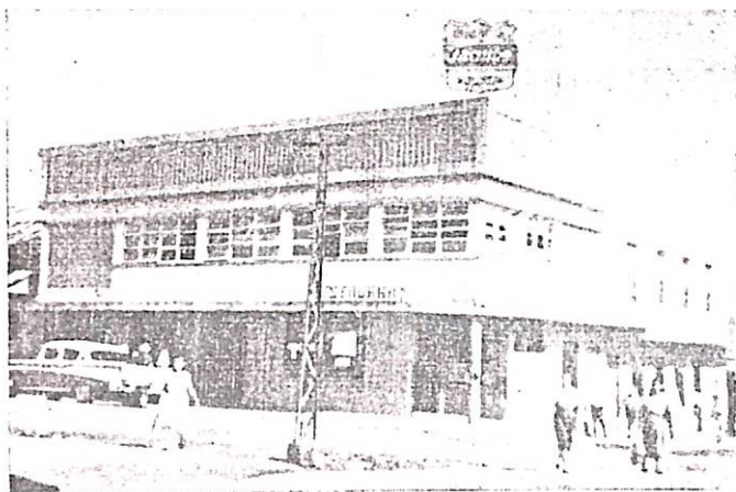
Edificio Quirós & Rodríguez
